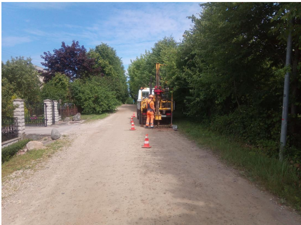
1 pav. Lauko darbai
